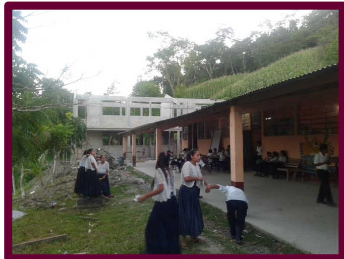
Figura 4. Instalaciones propias de Telesecundaria y construcción de cuatro nuevas aulas
