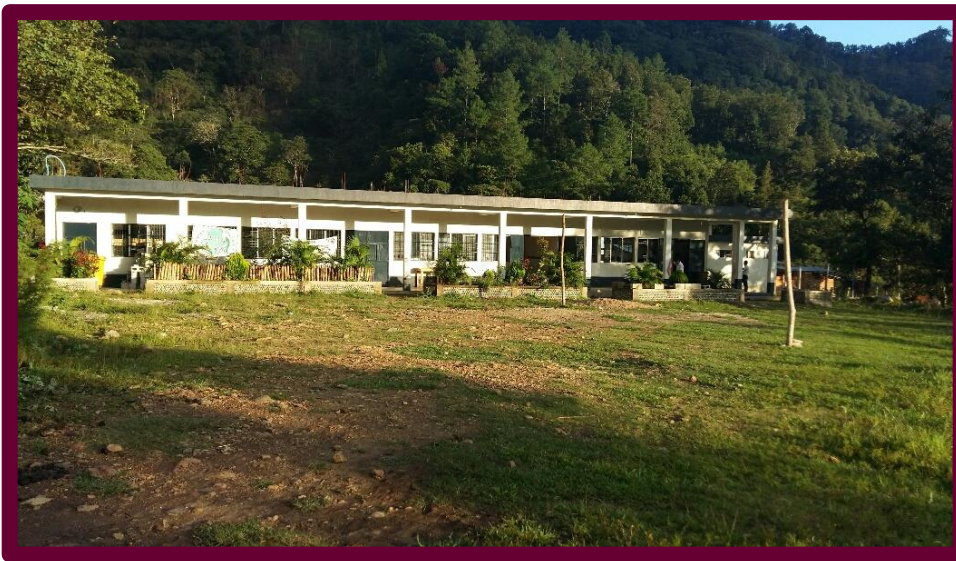
Figura 6. Instalaciones propias de la Telesecundaria
