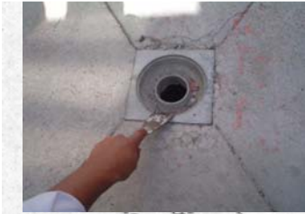
Limpieza constante de reposaderas y cajas de registro de agua pluvial.
