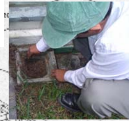
Extraer la basura acumulada en las cajas de registro y reposaderas.
