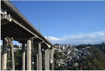
Puente «Martín Prado Vélez» o puente «El Incienso», construido por la gestión municipal de Manuel Colom Argueta.
