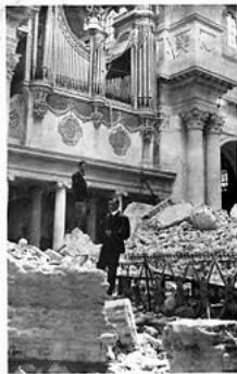
Efectos de los terremotos de 1917-18 en la Catedral metropolitana.
