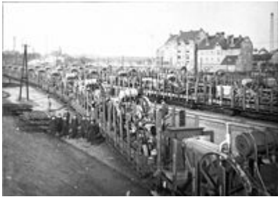
Tren transportando material de las reparaciones de guerra
