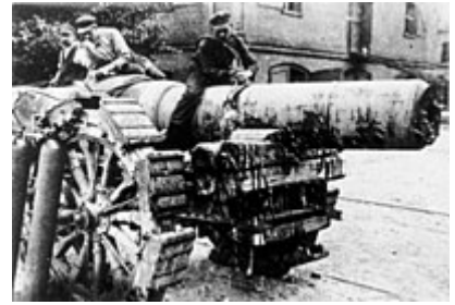
Fotografía de un archivo alemán (1920) ilustrando el desmontado de un cañón pesado, en aplicación de la disposición del Tratado a la destrucción de las armas pesadas.
